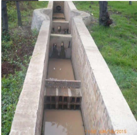
Fotografías 7 y 8: Instalación de filtros y cajas de pre-sedimentación antes de la descarga en el Punto PV1, comparación 2015 - 2018.
