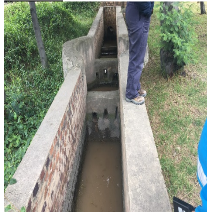
Fotografías 7 y 8: Instalación de filtros y cajas de pre-sedimentación antes de la descarga en el Punto PV1, comparación 2015 - 2018.
