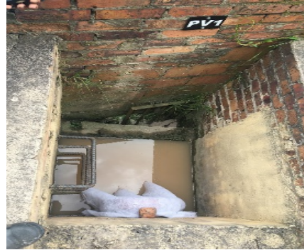
Fotografías 5 y 6: Punto PV1, lugar de descarga a la Quebrada Curí, comparación 2015 - 2018.
